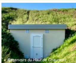
Réservoirs du Haut de Chaumont
