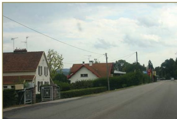
La RN 415 – rue de Colmar – un axe où logements et activités se sont greffés au fil du temps
