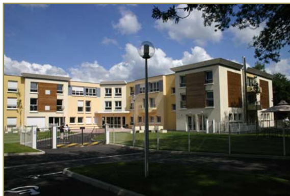
La maison de retraite des Aulnes – chemin de la cartonnerie.
