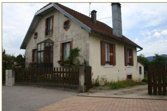
Une ferme traditionnelle et une maison d'ouvriers aux allures de ferme traditionnelle, rue d'Alsace
