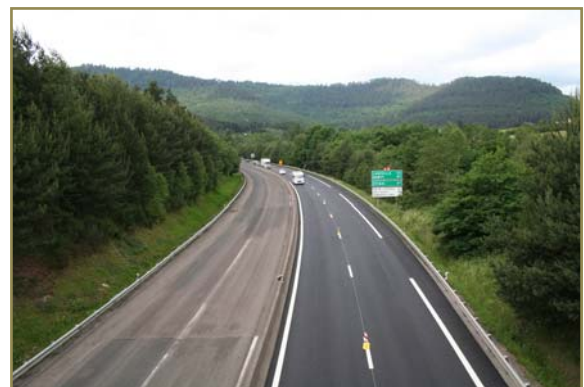
La construction de la RN59 a ponctionné sur la forêt
