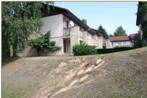
Traces de passage sauvage de cheminement piéton pour un accès direct inexistant.
