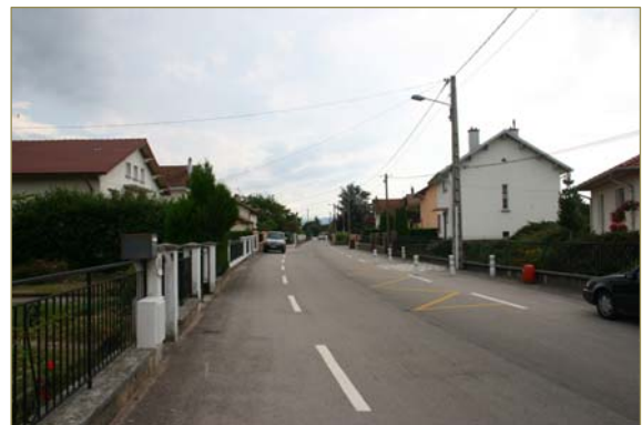
Maison de lotissement, rue des Roses ; Maisons loties le long de la rue de l'Etang
