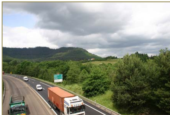
Vue sur la RN59, voie de contournement à fort trafic.
