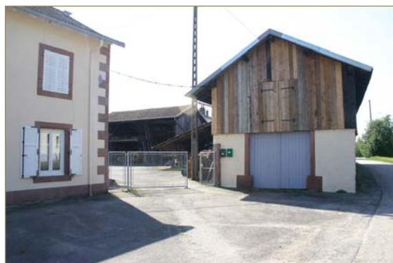
Ferme isolée à 3 travées, rue de Brompont Granges et dépendances, rue Louis Aubry
