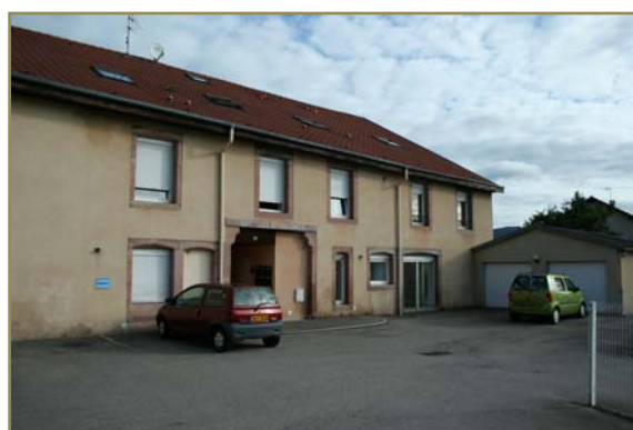
Transformation d'une ancienne ferme en logements collectifs
