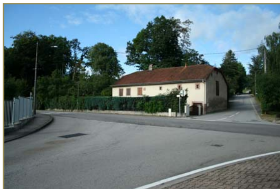
Une ferme isolée insérée dans le tissu urbain, rue des Déportés.
