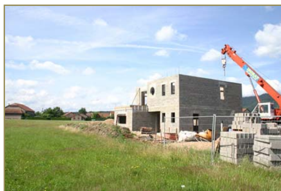
Chantier d'une maison individuelle située rue des roses
